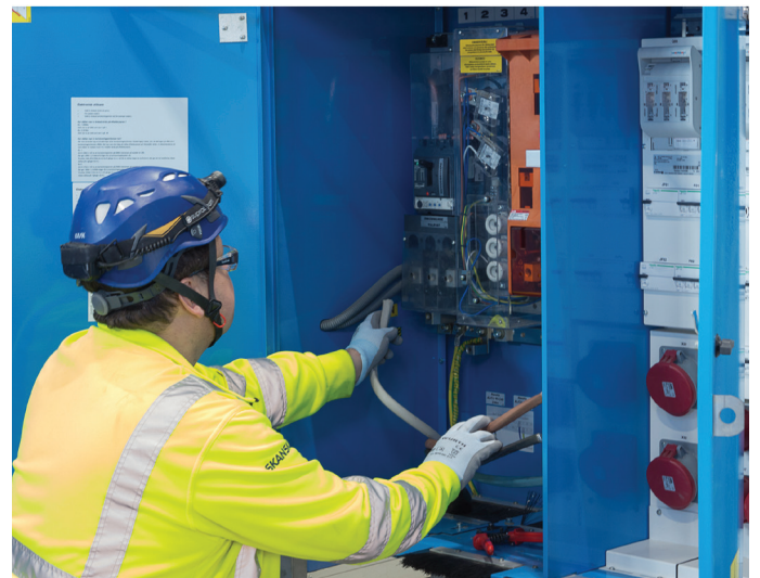
Ammattitaitoinen ja osaava henkilöstömme asentaa pää- ja alakeskukset, sekä valaistuskaluston työmaalle aina turvallisesti.
