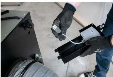
7. Tämän jälkeen voit liittää lisävarusteena olevan jatko kaapelin toisen pään paineentasaimen liitinrasiiaan, ja toisen pään paine-eroanturin liittimeen. Vakiomittainen jatkojohto 20m (lisävaruste).
