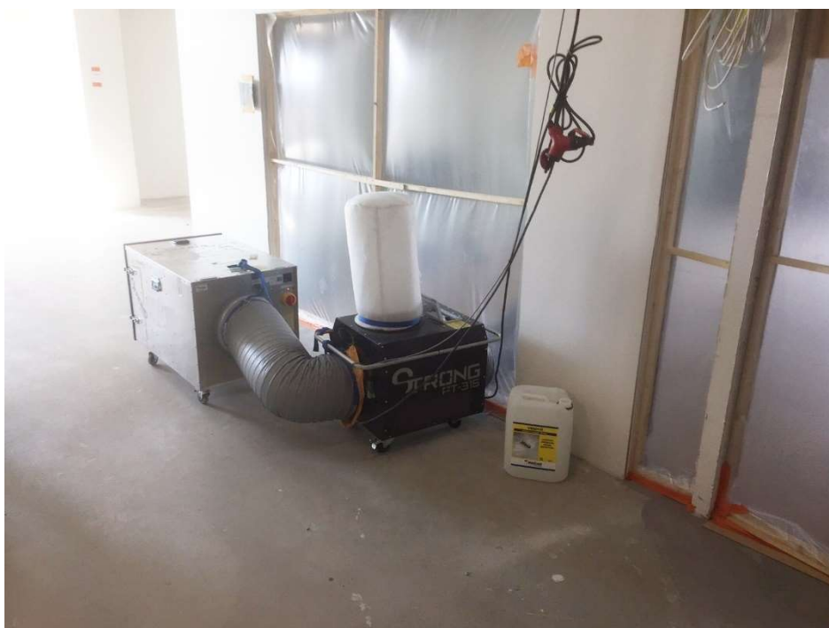
Esimerkkikuva rakennustyömaalta: Leikkaussalien väliaikainen ylipaineistus (ULS).
