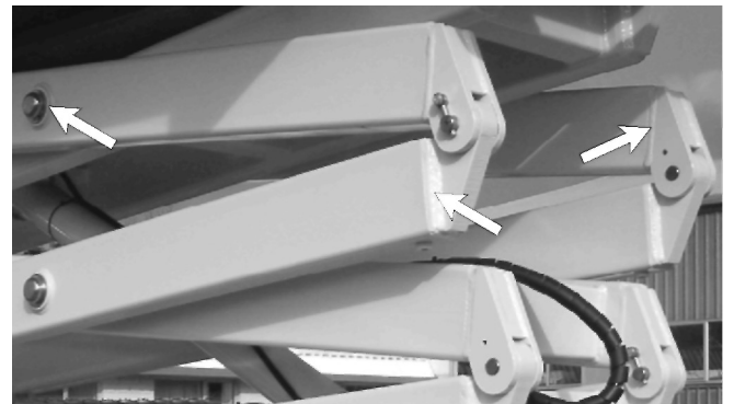
Kuva 7.19 - Rakennevauriot ja hitsausliitokset
